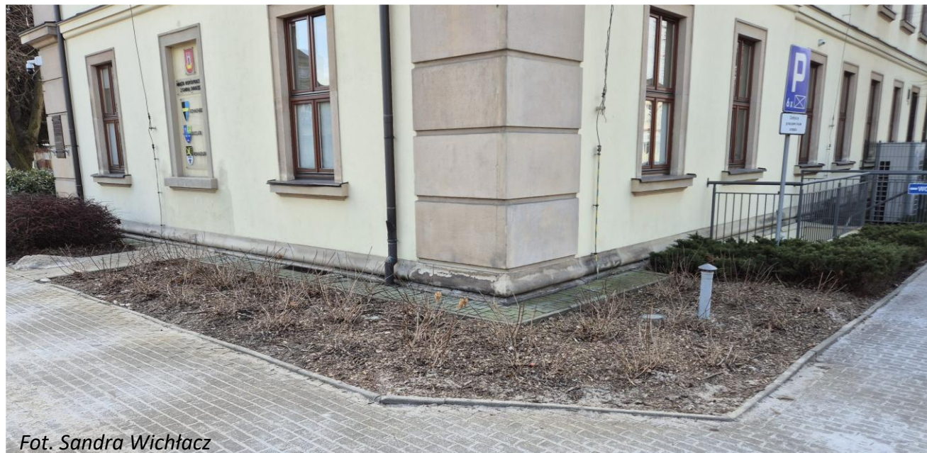
Rabata po modernizacji
