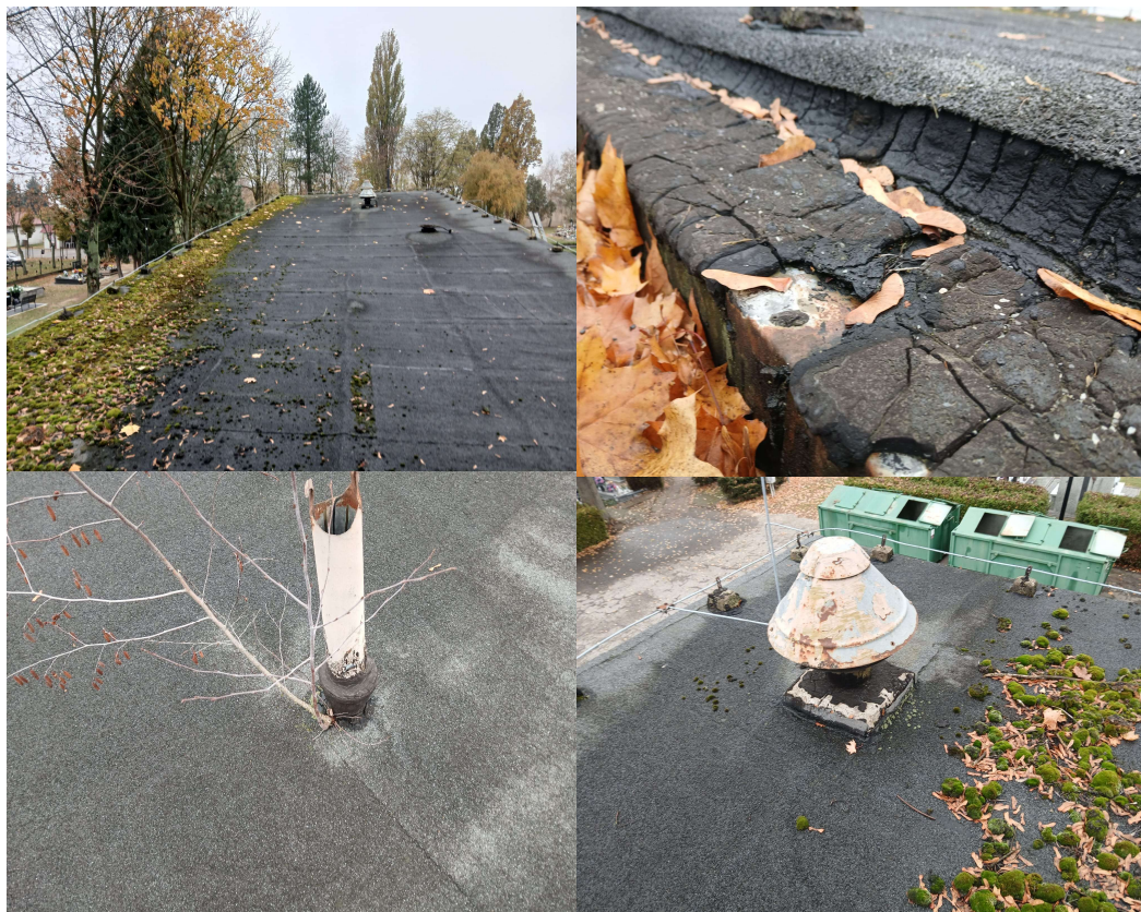
DACH PRZED REMONTEM
