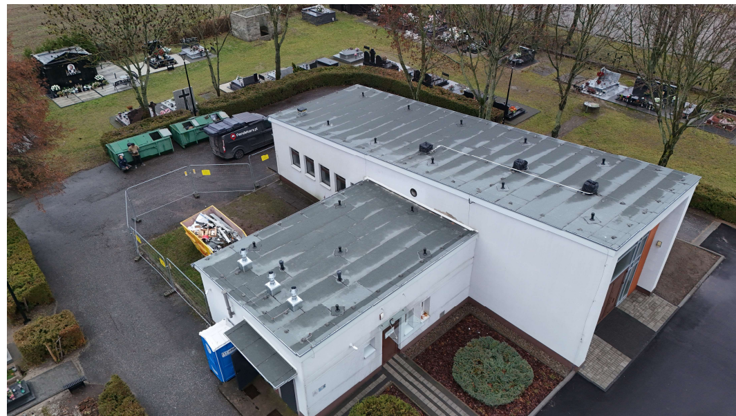
DACH PO REMONCIE
