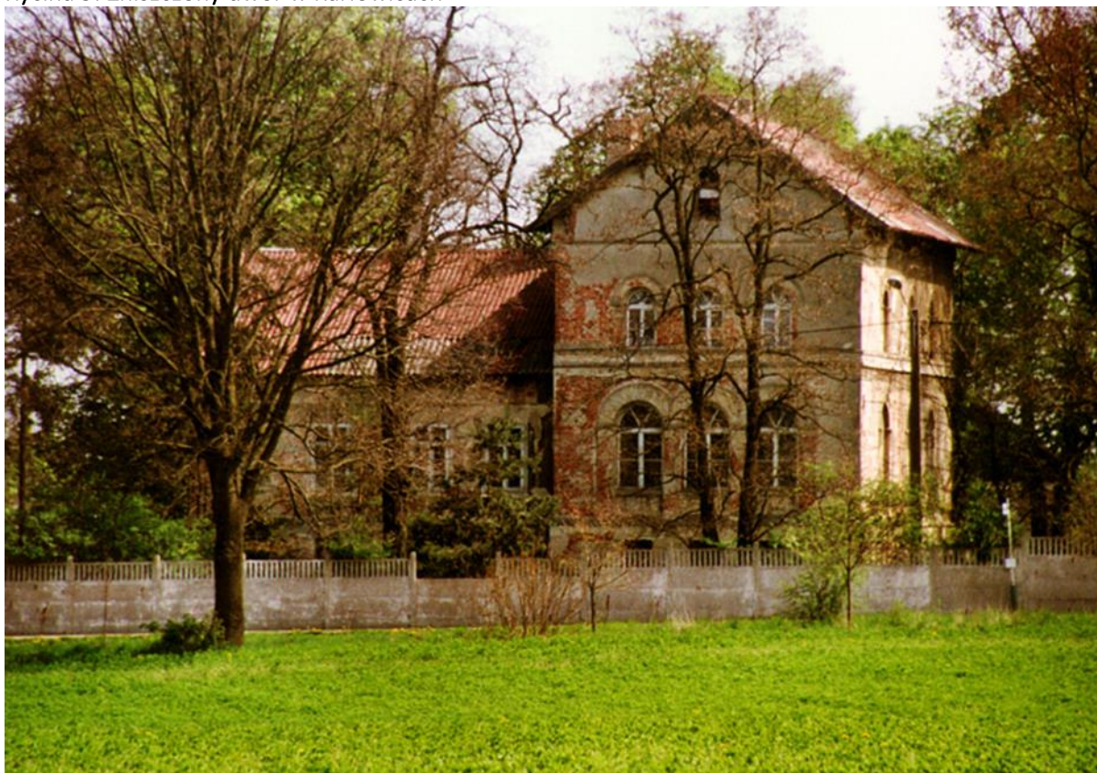
Rycina 9. Zniszczony dwór w Karłowicach
